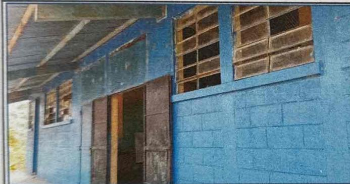
Foto 3: Sustitución de vidrios de ventales porque están quebrados y mantenimiento de tres puertas está en mal estado.
