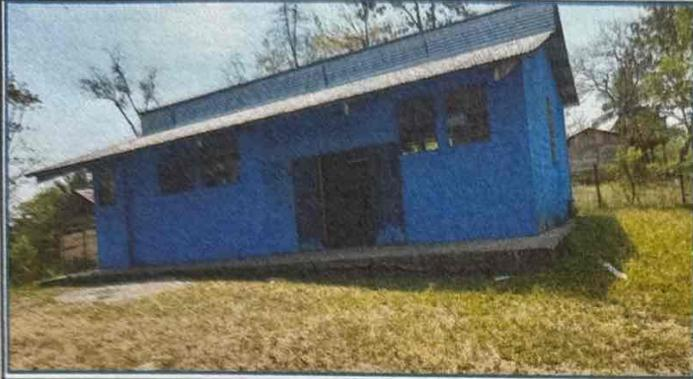
Foto 1: Sustitución de todas láminas de la escuela por que están en mal estado.
